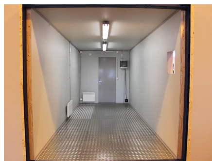
Sähköistys ja eristys
